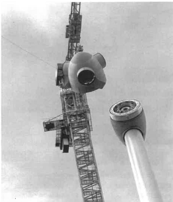
Fig. 3: Tête du rotor attachée
