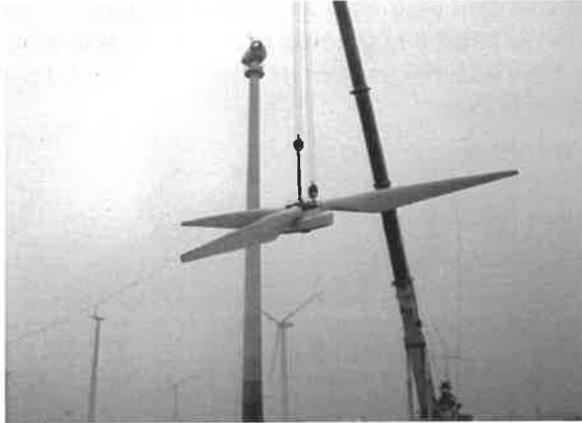
Fig. 2: Descente de la tête du rotor avec les pales
