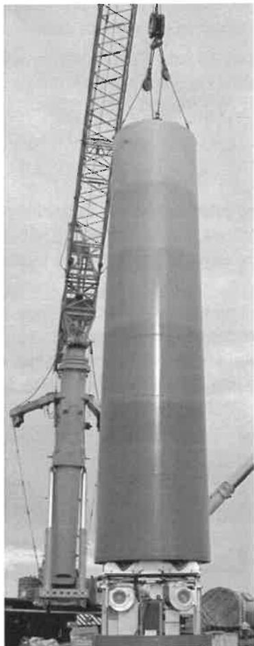
Fig. 5: E-module sous une section d'acier élinguée
